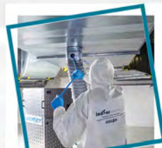
BONIFICA CON TECNOLOGIA COLLOM
